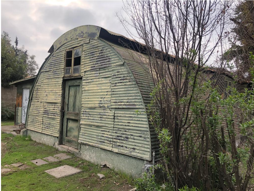
Fig. 3 – Um pequeno hangar construído pela Aéropostale em 1929, ainda pode ser visto em Colina. Foto: Norberto Traub e Juan Carlos Bascuñan. (2023).
