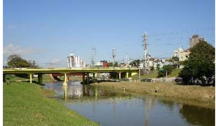
Ponte sobre o Rio Sorocaba.
