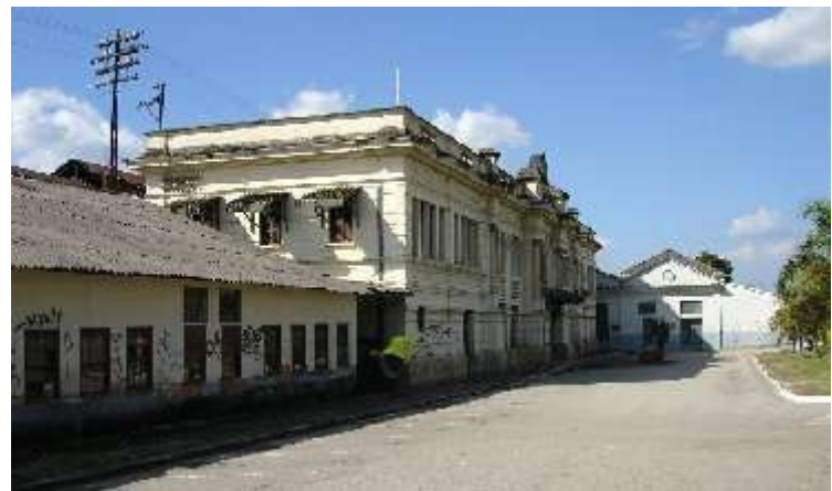
Estação da Estrada de Ferro Sorocabana. Foto PDDias - Junho de 2005.
