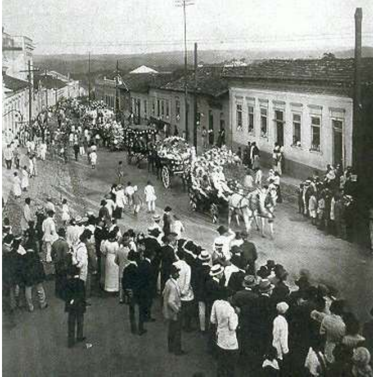
1903 - Corso carnavalesco na Rua da Ponte, hoje Rua Quinze de Novembro - Foto de Florentino Hansted.
