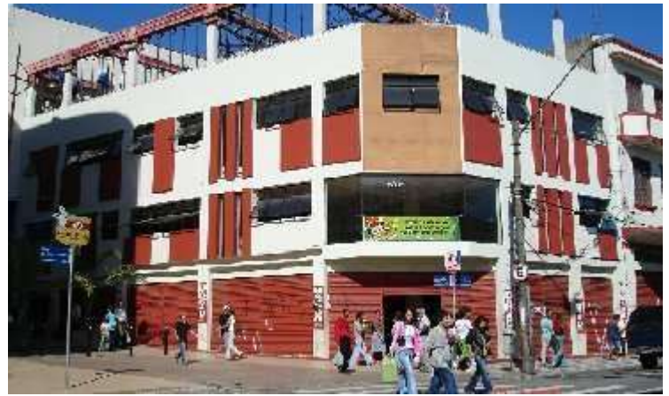
Prédio comercial (em reforma para abrigar nova loja) na Rua Barão do Rio Branco com a Rua Dr. Álvaro Soares.
