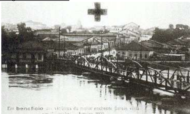
1929 - Enchente do Rio Sorocaba, na atual Ponte Francisco Delosso.
