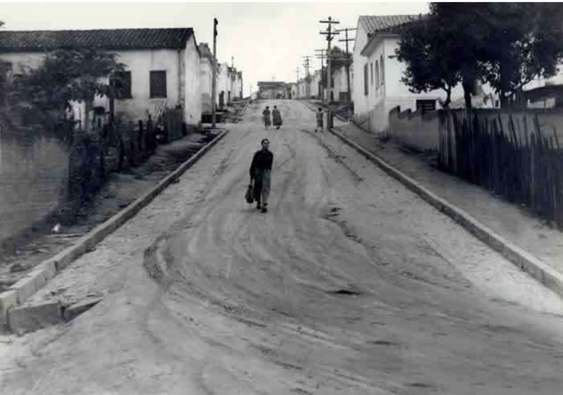
RUA ASSIS MACHADO, ALÉM PONTE.
